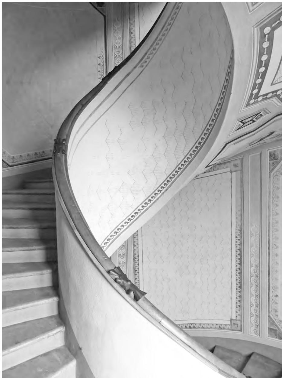
Fig. 17 - La scala elicoidale si proietta audacemente verso l'alto: la soluzione più adatta a vincere il dislivello disponendo di poco spazio (foto Massimo Dondi).
