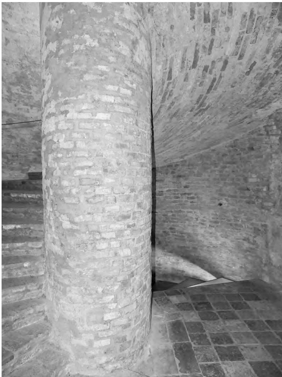
Fig. 14 - Il plinto in mattoni della scala che conduce dal pianterreno alle cantine seminterrate del Palazzo (foto Massimo Dondi).
